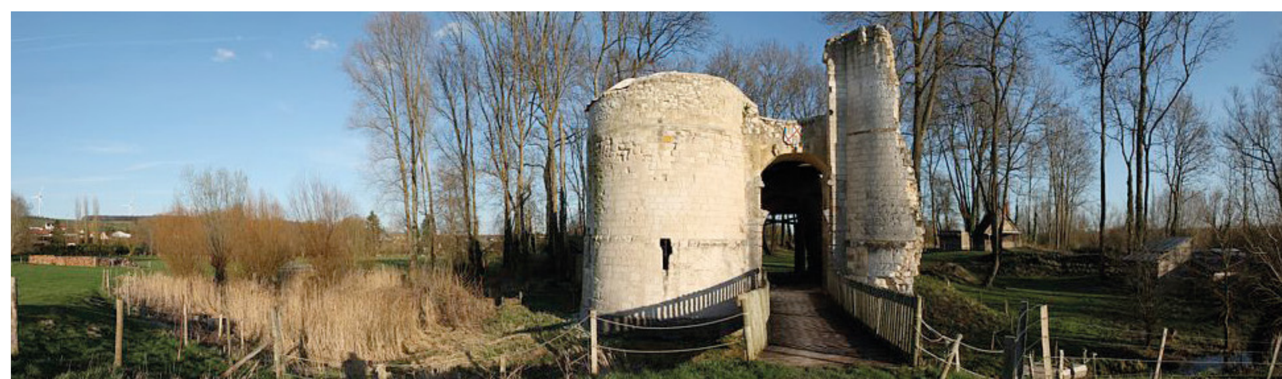
Vue panoramique du châtelet d'entrée (cliché A. Bron)
