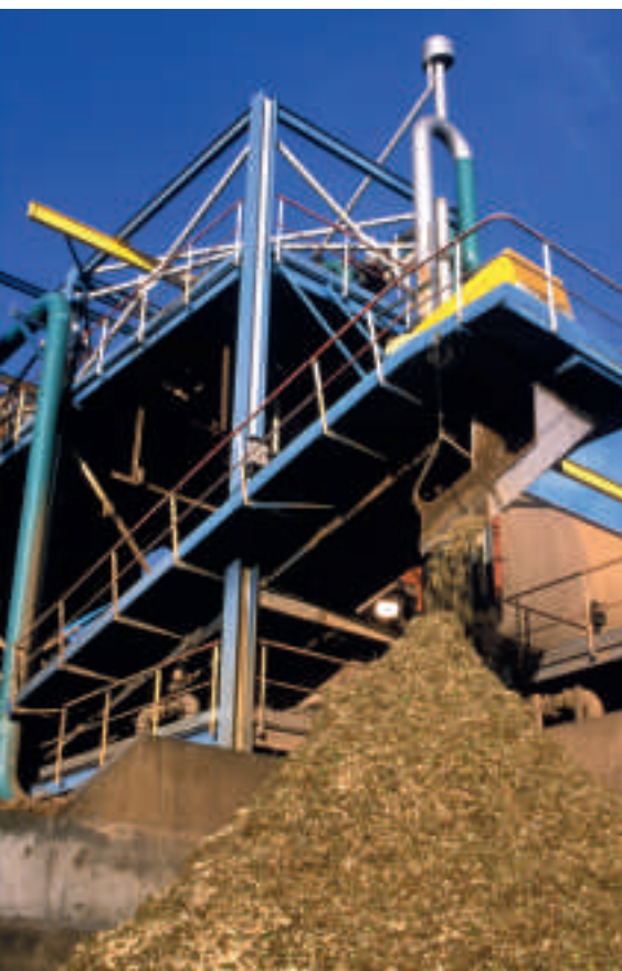
Déchets biogéniques issus du bois
